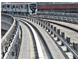
写真⑮ AGTのコンクリート走行路とガイドレール
